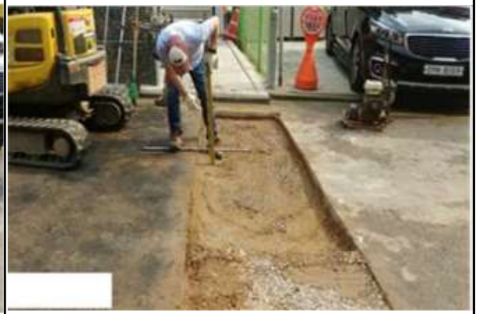
다짐 후 깊이 측정
