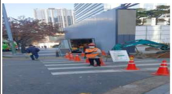
공사 안내간판 및 신호수
